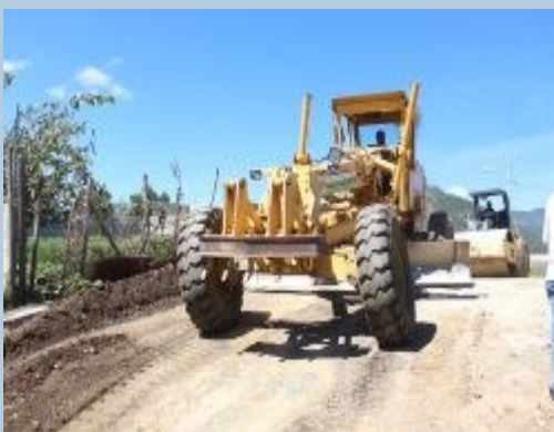
Rehabilitación calle La Pradera
