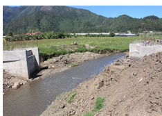
Construcción de puente
