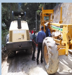
Rehabilitación de vía La Culata
