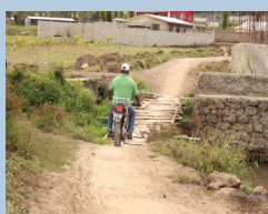
Puente en Las Auyamas
